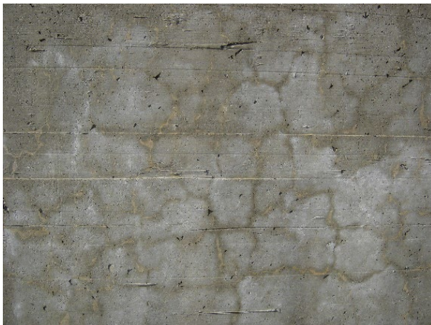
Mur pendant le traitement. Traité avec TEVEKASIL H5 B et H5 Gel. A droit vue après 3 ans.
