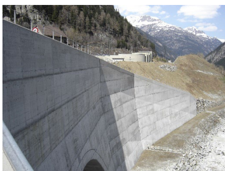
Façade avec béton préfabriqué âge 40 ans
