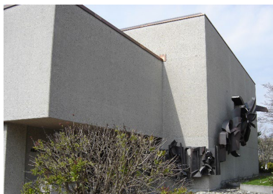
Façade entretien ; Surface boucharde. Vue après 20 ans traité avec TEVEKASIL KH (Consolidant) et TEVEKASIL H 5. Zone de protection > 25 mm. A droit détail de la structure superficielle.
