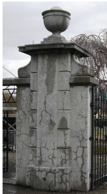
Béton et crépi au ciment. Fissures et RAG.
