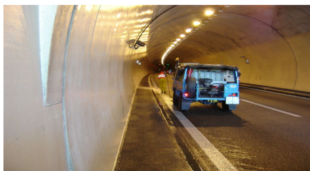
N5 Tunnel Bözberg nettoyage et traitement des bordures
