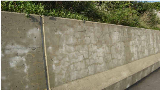
Mur de soutènement existante traité
