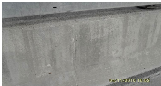
Parapet > 15 ans traité avec TEVEKASIL H5 sans corrosion des armatures
