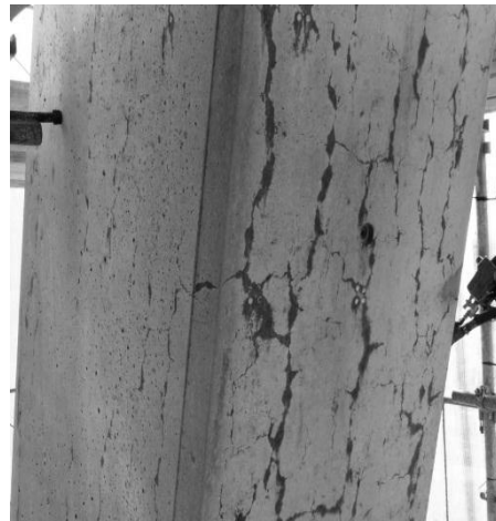
Pylon Itenhard Conservation Pilier avec peinture/lasure et RAG. Nettoyage à sec et traitement avec TEVEKASIL H5 Gel
