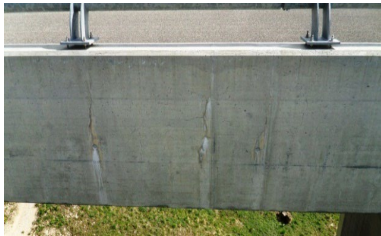
Parapet 5 ans après construction. (Extérieure)
