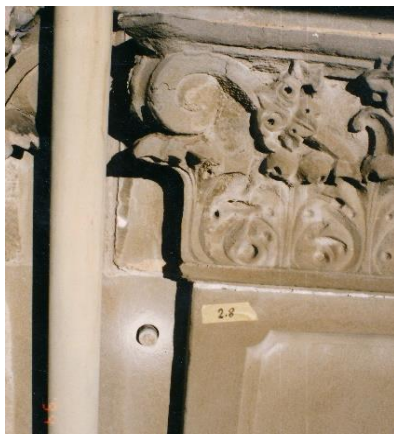
Probenentnahme und Salzsprengetest mit Maulbronner, Ostermundigen und Mailänder Stein
