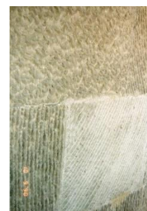
Molasse Sandstein Reinigung, Substanzerhaltend und Konservierung
