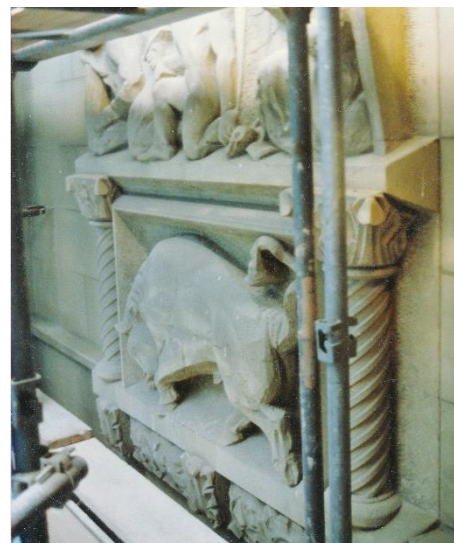
Rathaus Bern Reinigung der Sandsteinfassaden und Figuren manuell.. Teilweise Festigung mit Kieselsäureester und Hydrophobierung. Moosentfernung
