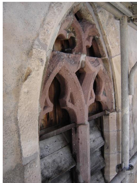
Eglise Saint-Dominique in Wattwiller Vorprüfung, Steinverfestigung- Bindemittelzufuhr Ergänzungen, schliessen von Rissen. Konservierung von Einfassungen, Pfeiler und Statuen an Rouffacher- und Vogesensandstein Verputzreinigung für neuen Kalkputz Eglise de Vieux Thann Konservierung der Figur
