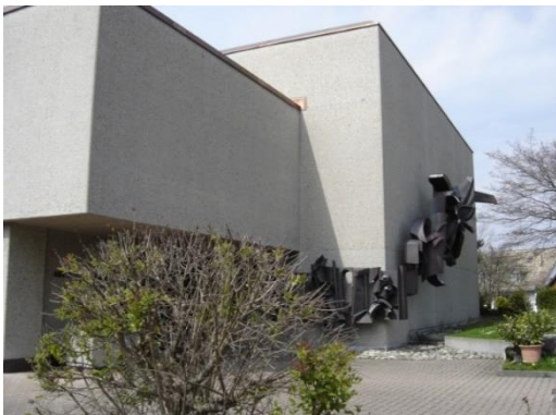
Betonfassade mit gestockter Oberfläche. Konservierung und Hydrophobierung
