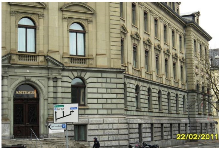
Amthaus Kanton Bern Mittelrisalit und Hodlerstrasse 1982. Aufnahme 2011. Ostermundigen Sandstein behandelt mit TEVEKA Steinfestiger. Stabilisierung mit Tiefenwirkung bis zu 80 mm. Nachprüfung 2024. Ansicht vor der Reinigung und Konservierung
