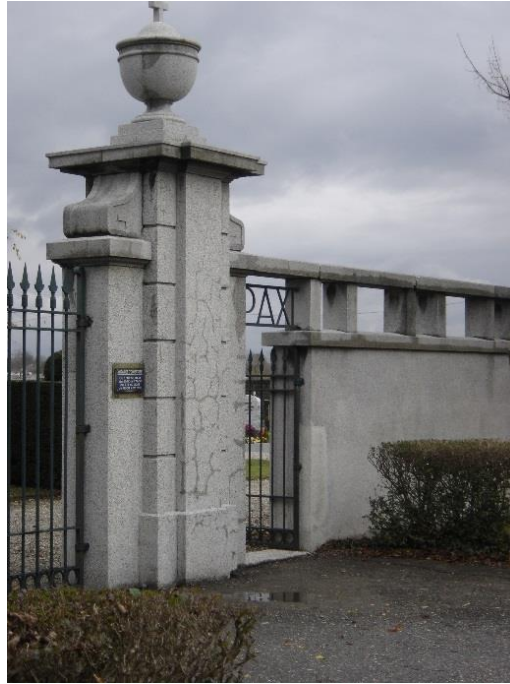
Beton und Mörtel mit Alkali Reaktionen
