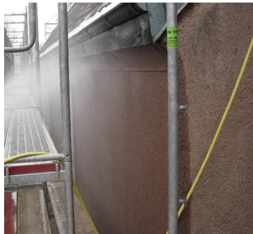
Reinigung von rotem Sandstein. (Grès de voges Voltizia) Graffiti Entfernung mit Warmwasser ohne Reinigungschemikalien.
