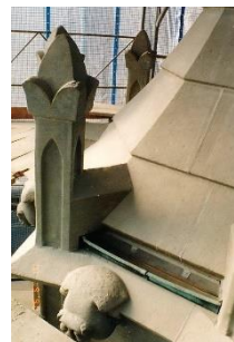
Molasse Sandstein Reinigung, Substanzerhaltend und Konservierung
