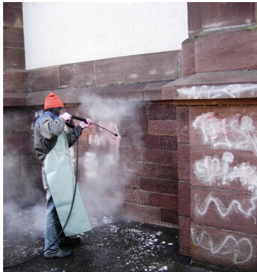
Reinigung von rotem Sandstein. (Grès de voges Voltizia) Graffiti Entfernung mit Warmwasser ohne Reinigungschemikalien.
